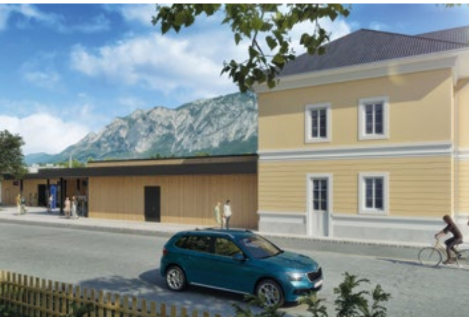
Der Bahnhof Arnoldstein wird barrierefrei erschlossen, der Vorplatz und der Zugangsbereich überdacht sowie mit Park & Ride-Anlagen versehen. Fotos: ÖBB, Gemeinde
