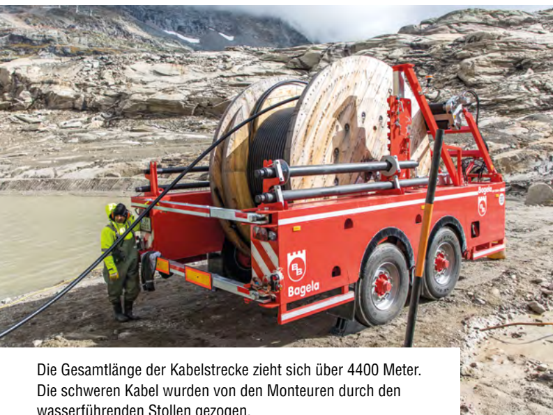
Eine Baustelle der Superlative – in schweißtreibender, nicht ungefährlicher Arbeit werden von den Monteuren die schweren Kabel verlegt.
