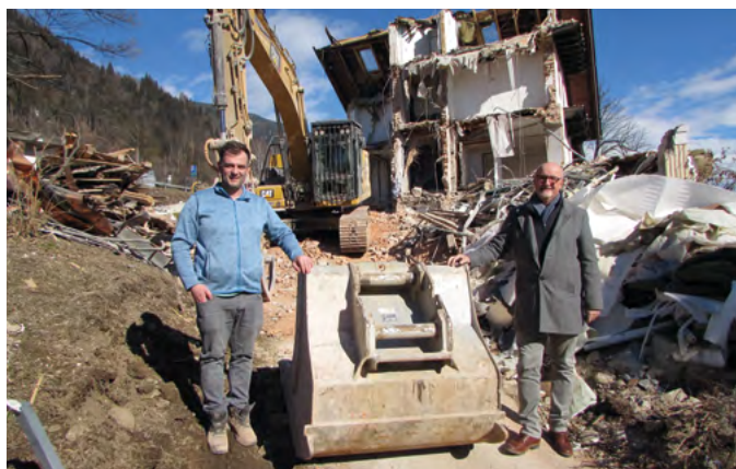
Bürgermeister Klaus Glanznig (rechts) und Bauleiter Emanuel Peinhopf (EAR GmbH) bei einem Lokalausgesehen.
