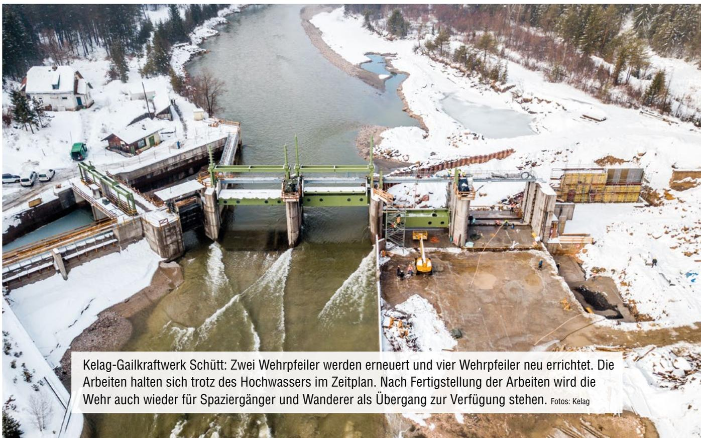
Kelag-Gailkraftwerk Schütt: Zwei Wehrpfeiler werden erneuert und vier Wehrpfeiler neu errichtet. Die Arbeiten halten sich trotz des Hochwassers im Zeitplan. Nach Fertigstellung der Arbeiten wird die Wehr auch wieder für Spaziergänger und Wanderer als Übergang zur Verfügung stehen. Fotos: Kelag
