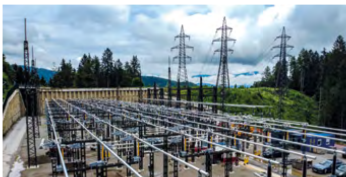
Derzeit wird die Hochspannungsanlage montiert.
